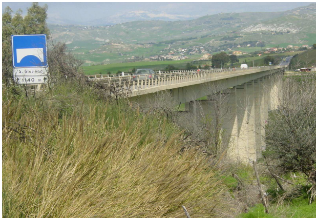
Particolare pila ed impalcato N°6579
