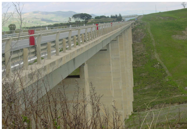
Particolare pila ed impalcato N°6582
