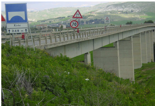
Particolare pila ed impalcato
