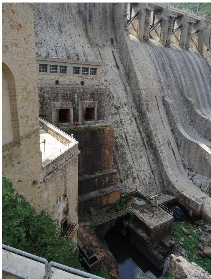
**Figura 3:** Diga di Muzzone – Vista da valle: Stato di fatto scarico di fondo e scarico di alleggerimento.
