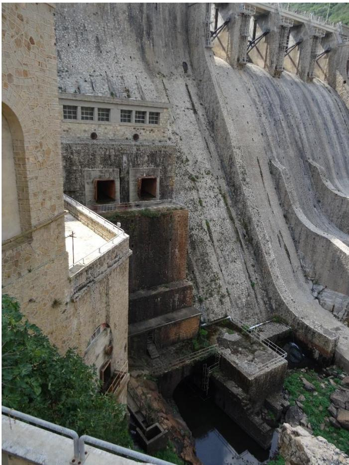
**Figura 4:** Diga di Muzzone – Vista da valle: Stato di fatto scarico di fondo e scarico di alleggerimento.
