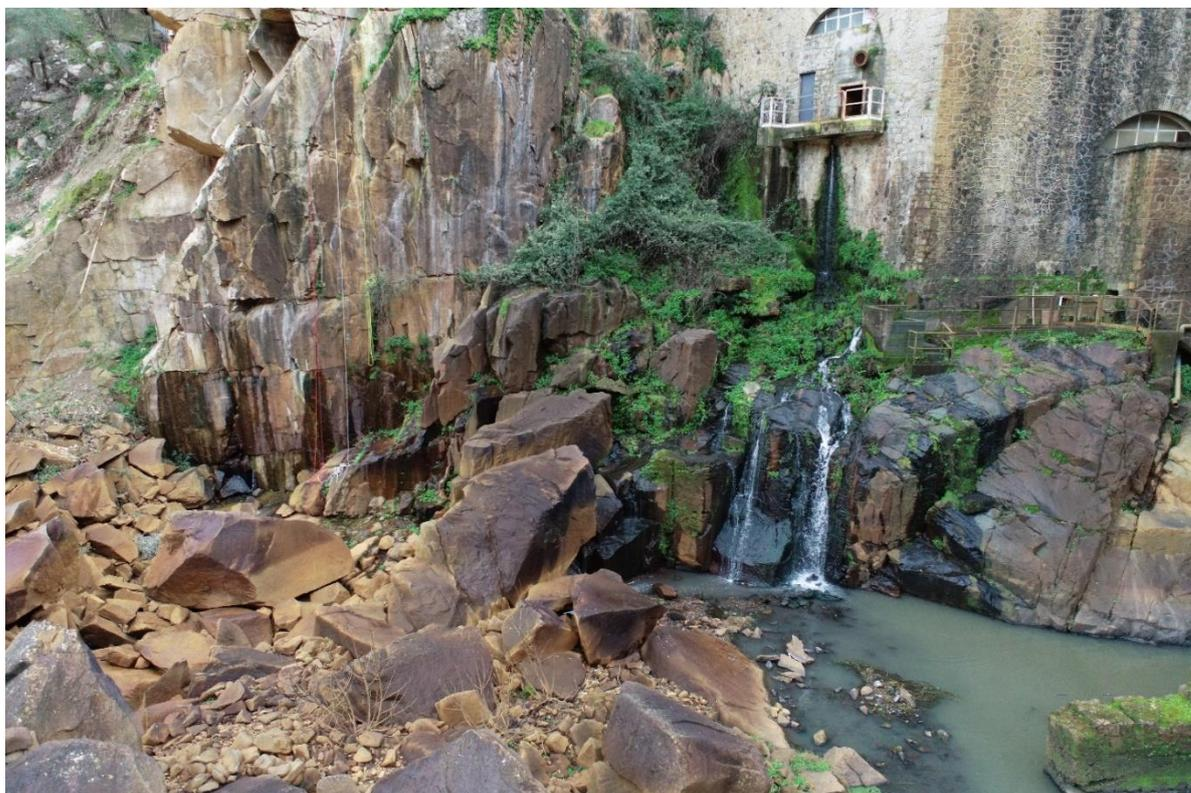
**Figura 2:** Perdite d'acqua in roccia in corrispondenza della sponda destra a valle diga.
