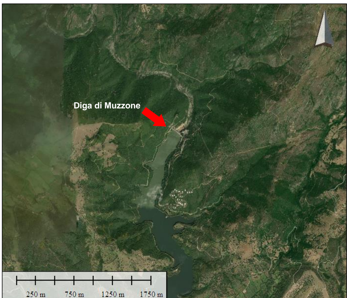
Figura 1: Ubicazione diga di Muzzone.
