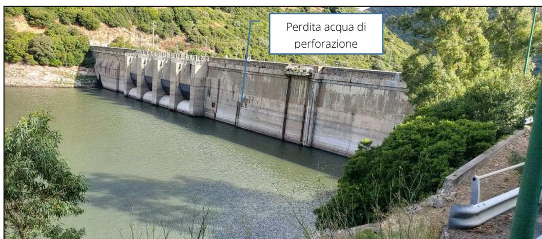
Figura 5 - Paramento di monte- fuoriuscita acqua di perforazione
