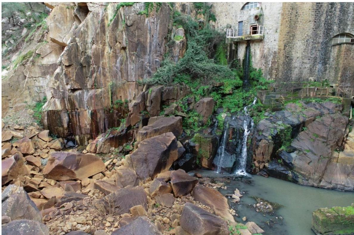
**Figura 1:** Perdite d'acqua in roccia in corrispondenza della sponda destra a valle diga.
