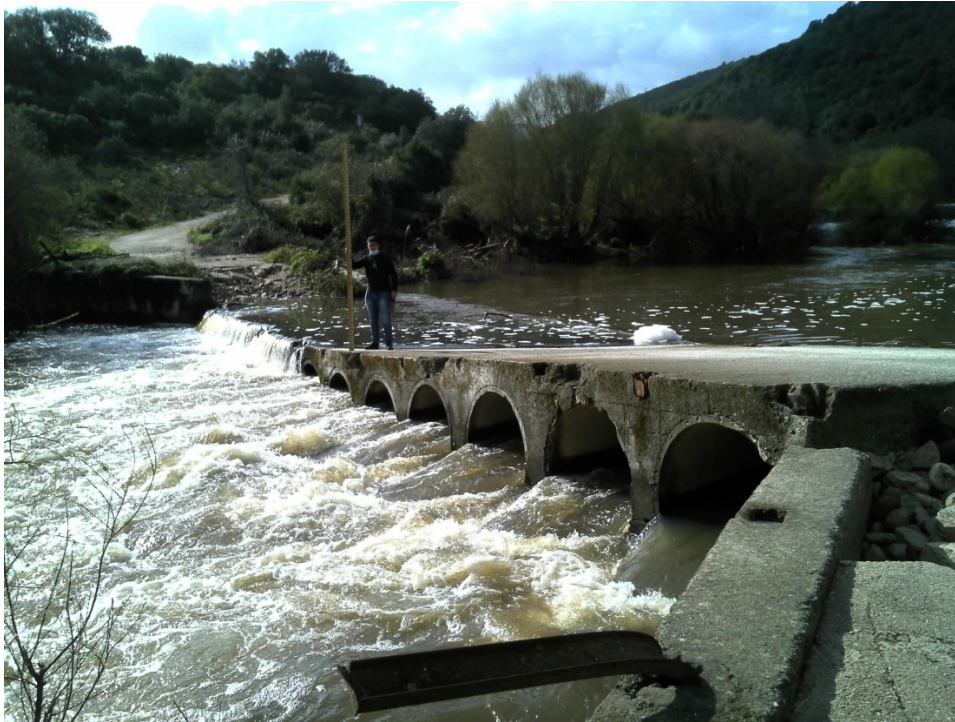
Figura 2: Esempio di rilievo fotometrico delle accidentalità trasversali a valle diga: guado P2.
