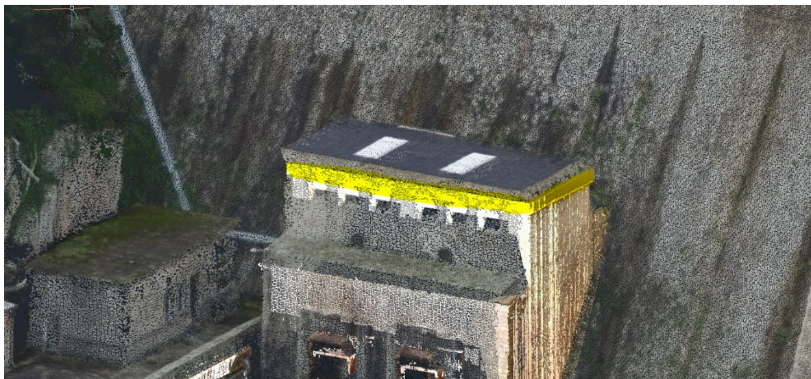
Figura 1: Sovrapposizione fra nube di punti ed architetture esistenti della struttura, fabbricato di manovra degli scarichi intermedi sul paramento di valle.
