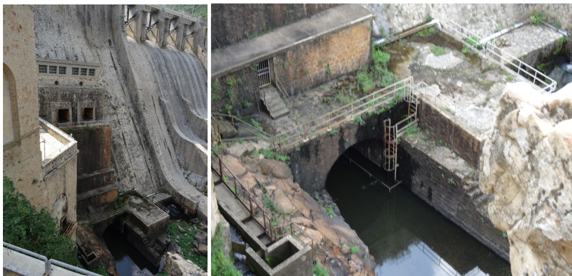
Figura 5: Diga di Muzzone – Vista da valle: Stato di fatto scarico di fondo e scarico di alleggerimento.
