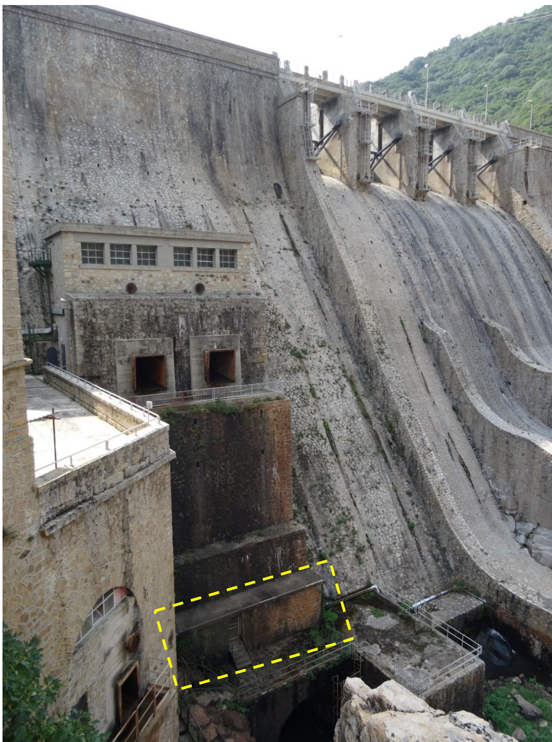
Figura 50: Punto 1 - Diga di Muzzone, ripresa fotografica da valle. In basso è visibile il fabbricato esterno di accesso ai cunicoli e alle gallerie interne afferenti allo scarico di fondo che si prevede di demolire e sostituire (evidenziato dal tratteggio in giallo).
