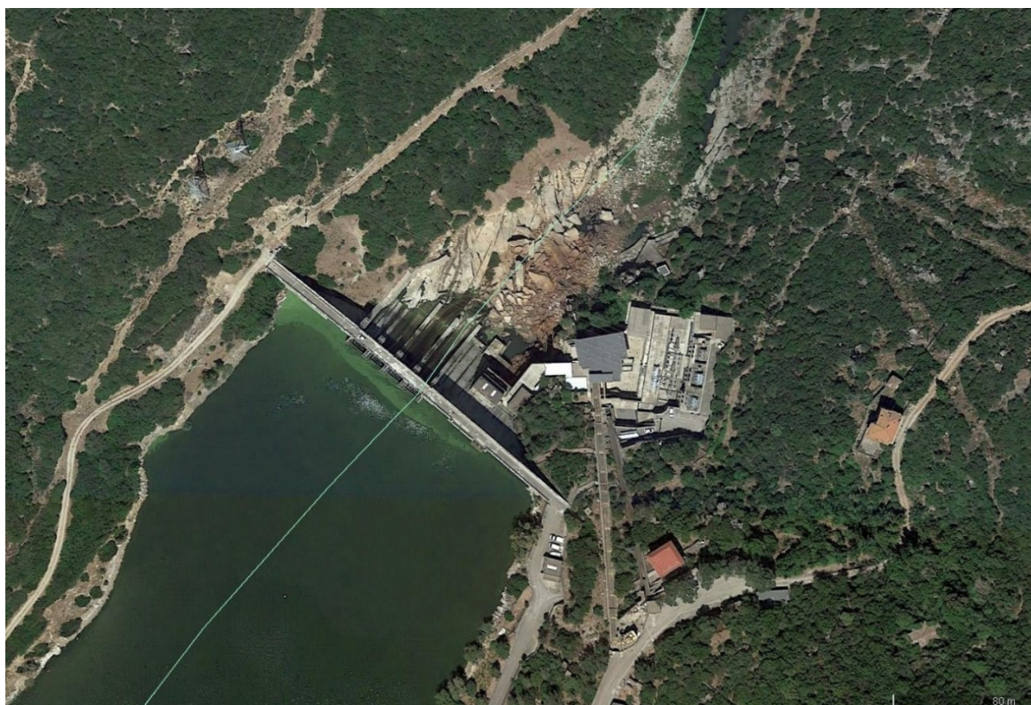
Figura 1: Aerofoto della diga di Muzzone.
