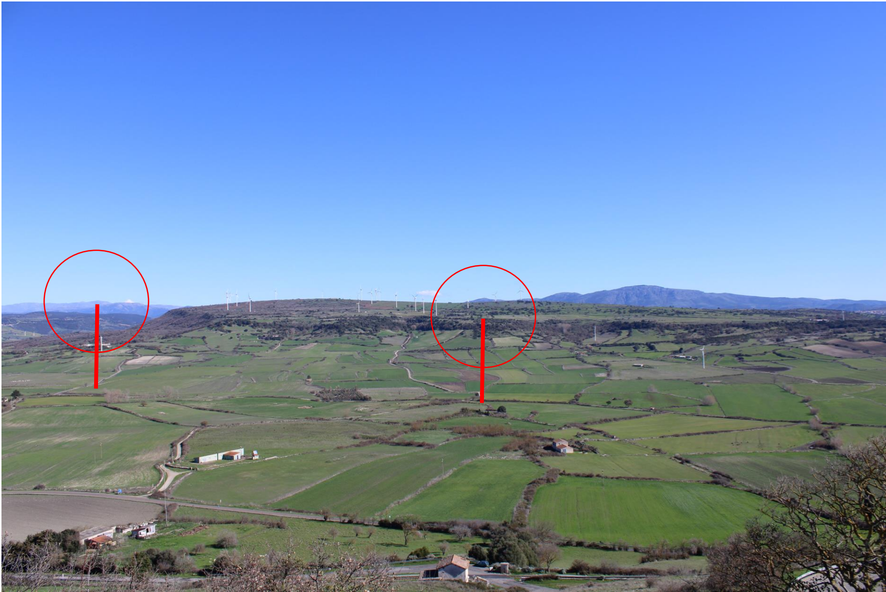
POST INTERVENTO – Aerogeneratore WTG4 e WTG6 Parco eolico Nurri –Località “Guzzini
