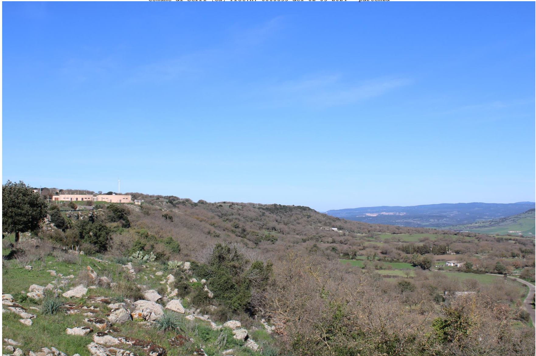
ANTE INTERVENTO – Aerogeneratore WTG5 Centro Servizi per l’area Archeologica di Santa Vittoria Località “Sa Perda Ballo”
