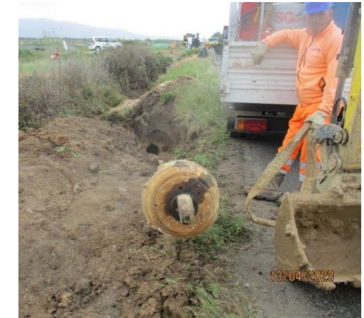
Fresa da 50 cm per la preparazione del foro ove posare il fascio dei tubi di PE
