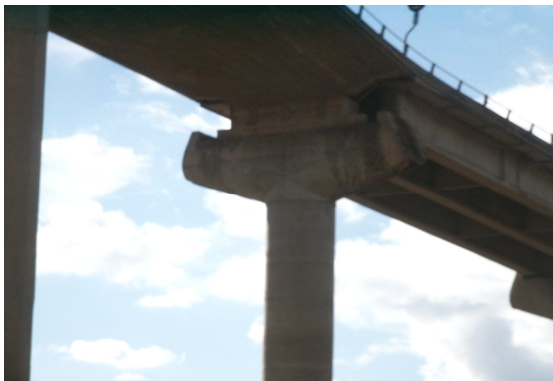
Particolare pila finale ed impalcato
