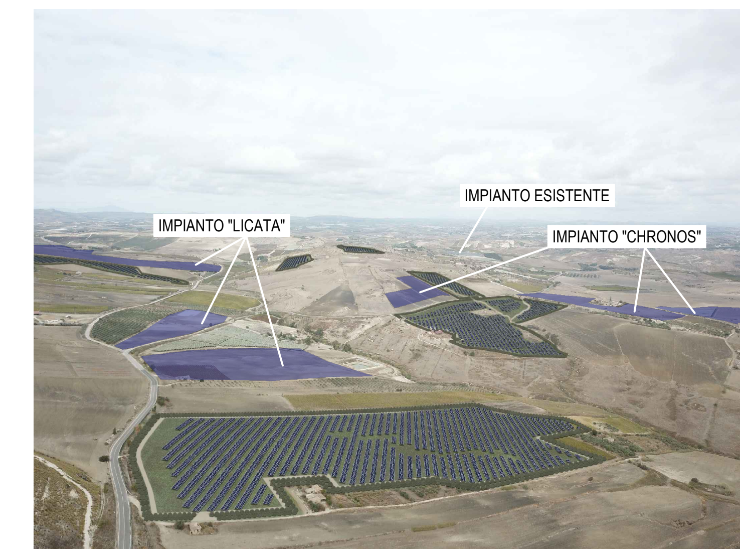
Punto di ripresa n°4 post operam con cumulo impianti esistente e in autorizzazione "Licata" e "Chronos"
