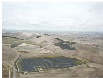
Fotosimulazione dell'impianto con moduli con tecnologia antiriflesso in silicio monocristallino.
