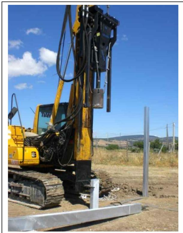
**Fig. 7.2.3 - Rappresentazione del sistema di infissione**
