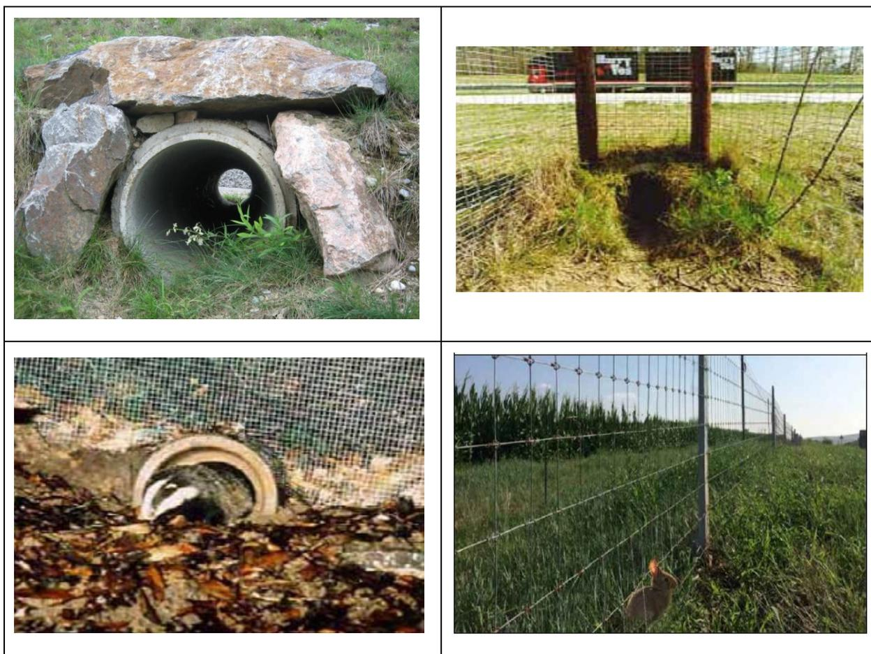
*Figura 6 - Esempi di tipologie di sottopassi per la fauna che saranno realizzati*
