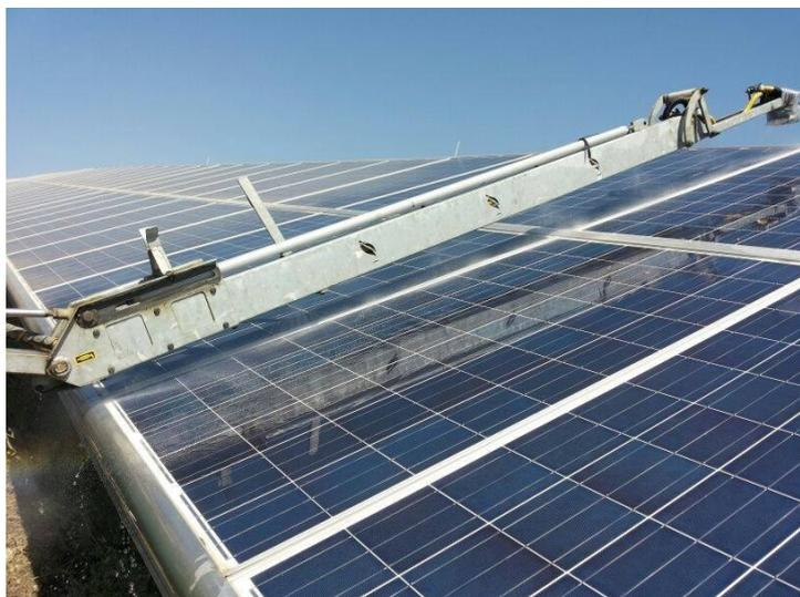
Figura 12 – Operazioni di pulizia moduli effettuate con sistema atomizzatore con uso esclusivo di acqua.
