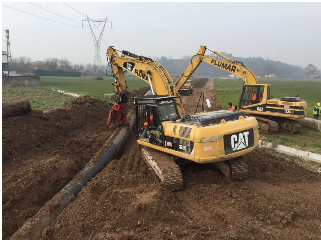
Fig. 4.1.1.6 – Esempio Dismissione condotta (le dimensioni della condotta in foto sono superiori a quella in progetto)
