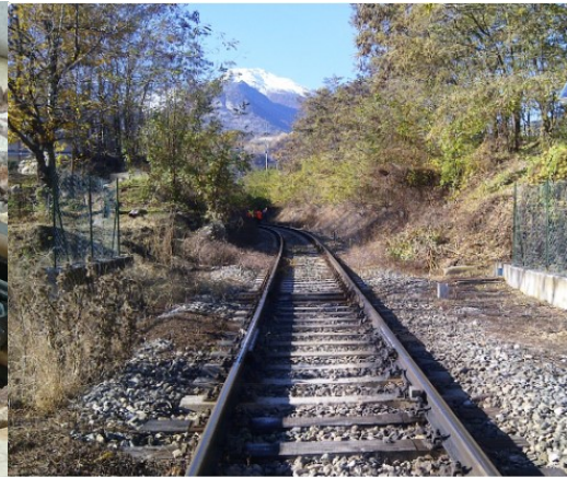
Impianto lubrificazione P.A.L. Italia (Foto: P.A.L. Italia; 2012)
