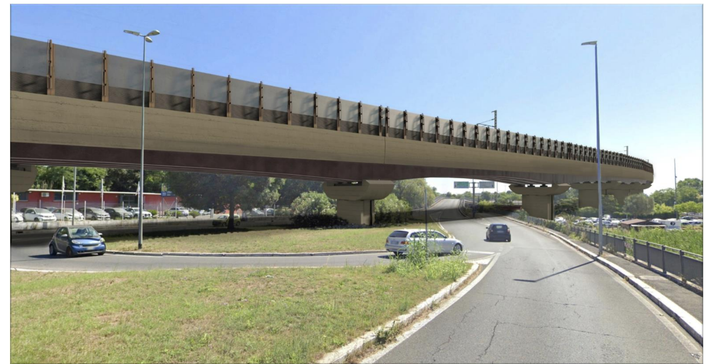
Figura 5-20 Stato post operam
