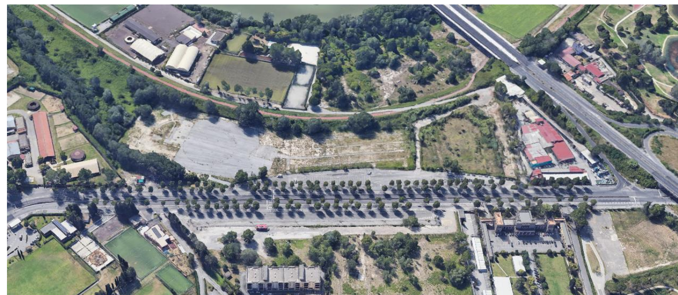
Figura 5-7 Aree di cantiere CO1-01 e CB1-01
