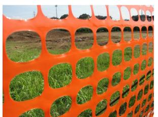
Reti in polietilene ad alta densità di colore arancione fissata tramite filo metallico su pali infissi nel terreno
