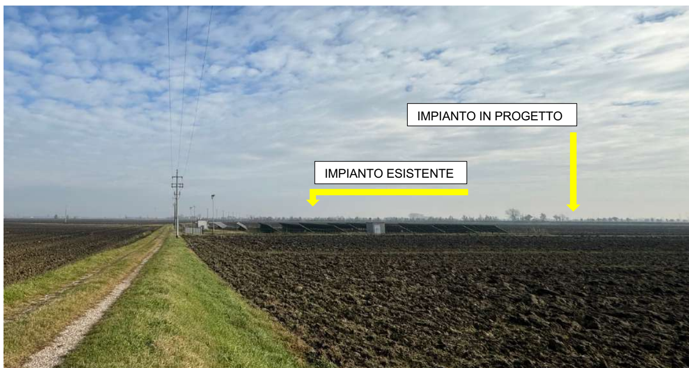
Figura 3.11 FOTO B impianto esistente
