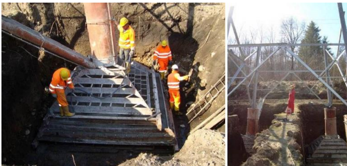
Figura 6-23 – Realizzazione piedino del traliccio
