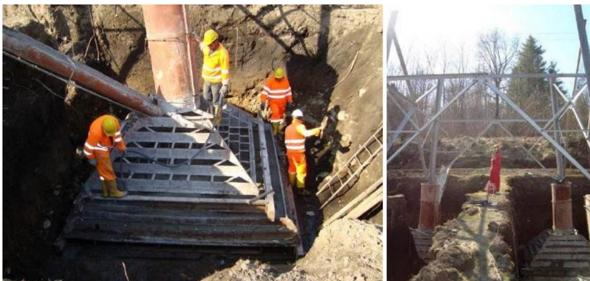
Figura 7-9 – Realizzazione piedino del traliccio
