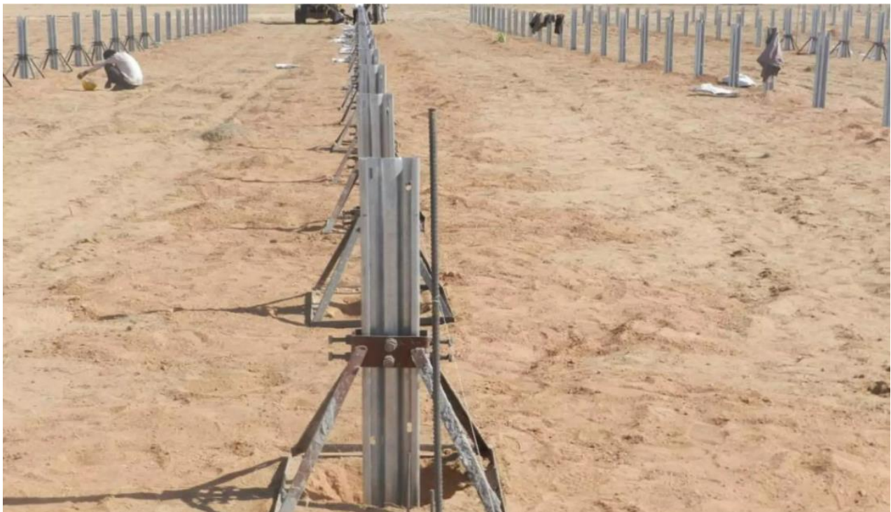
Figura 6-3 - Esempio di pali degli inseguitori infissi nel terreno
