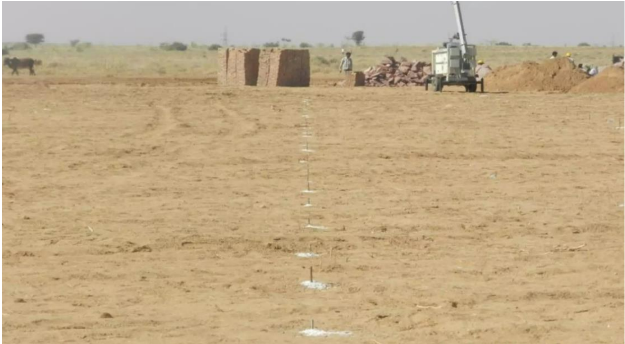
Figura 6-2 - Marcatura per infissione pali degli inseguitori solari
