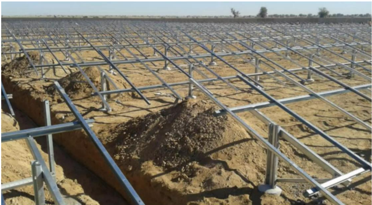
Figura 6-4 - Esempio strutture trackers montate
