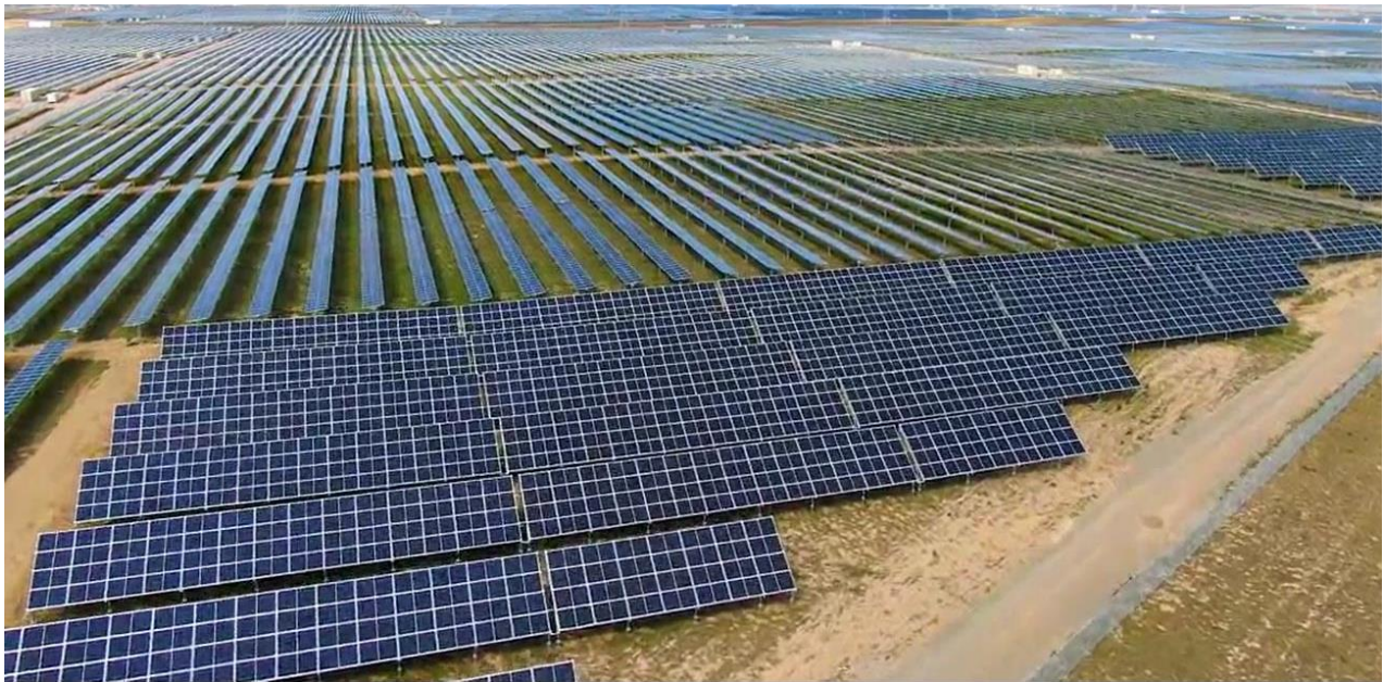
Figura 5-3 – Differenza di occupazione tra strutture fisse (sotto) e ad inseguimento solare (sopra)
