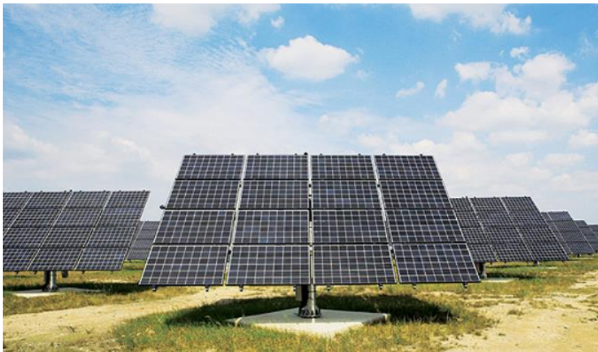
Figura 5-2 – Tipologico inseguitore solare biassiale
