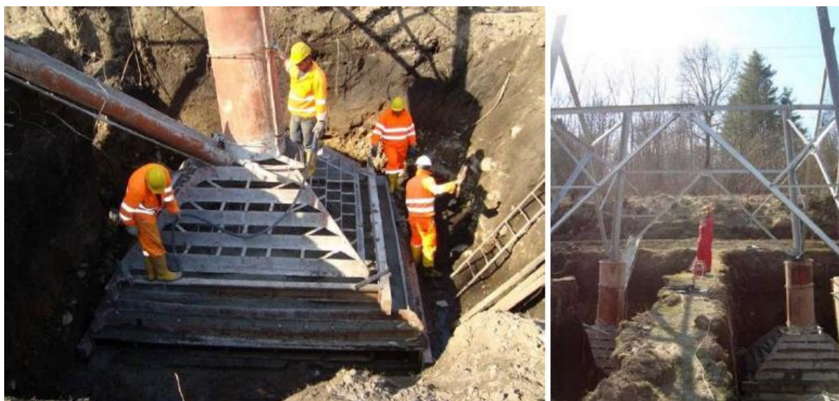
Figura 6-20 – Realizzazione piedino del traliccio
