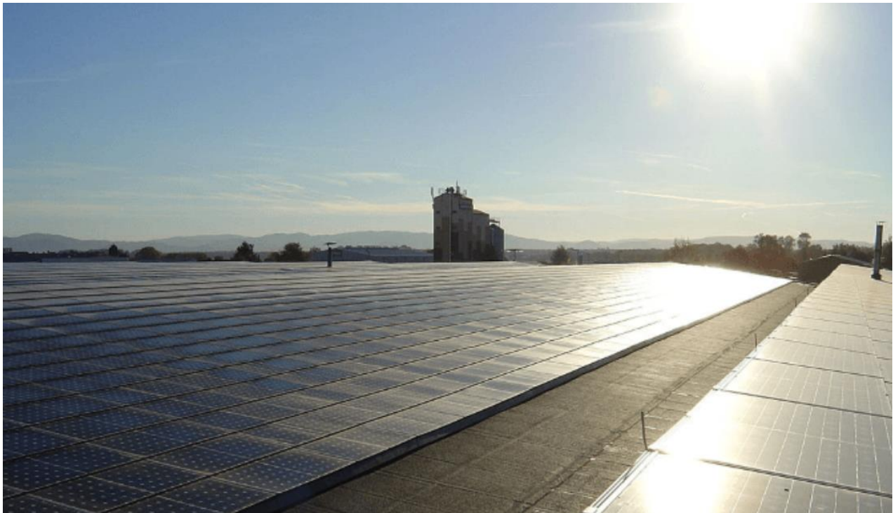
Figura 6-1 – Esempi tipici di abbagliamento causato da superfici riflettenti
