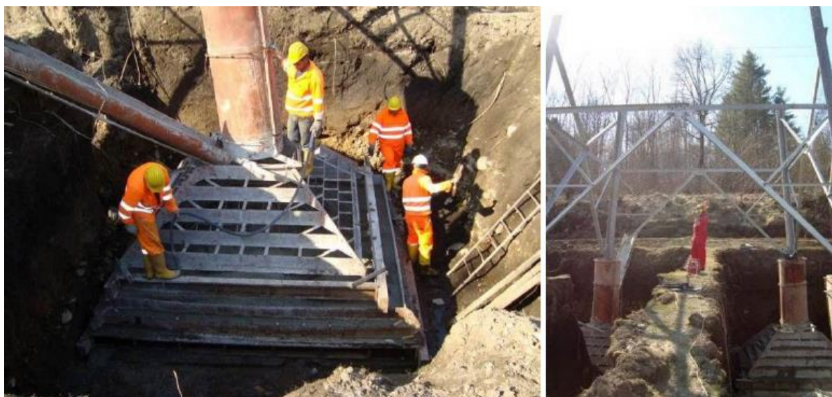
Figura 6-15 – Realizzazione piedino del traliccio
