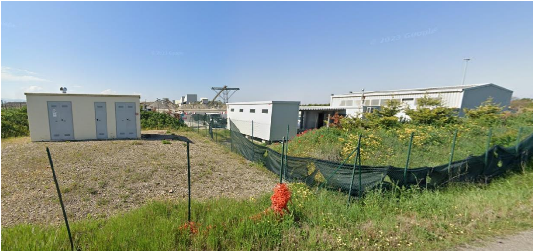
Figura 8-6 - Fotografie di locali e impianti tecnici ubicati nel territorio limitrofo all’area di progetto.
