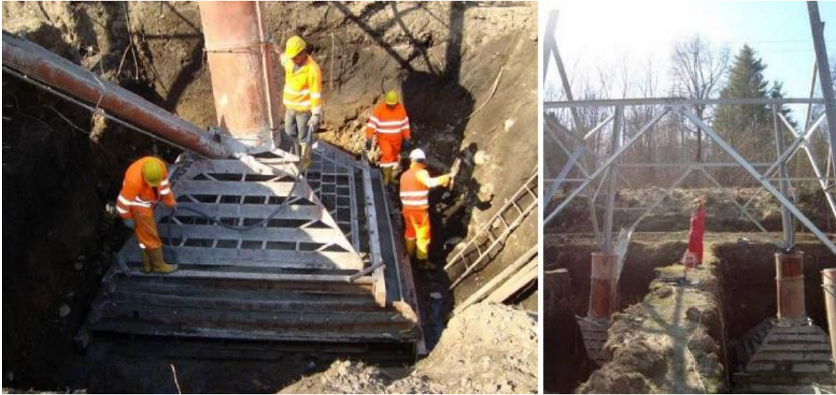
Figura 6-15 – Realizzazione piedino del traliccio
