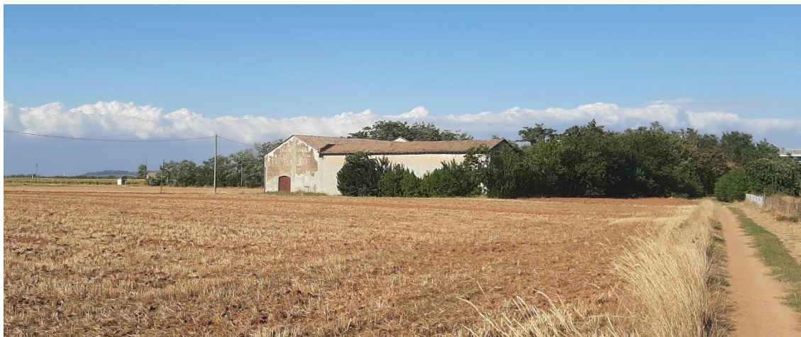
Figura 8-3 - Fotografia della Cascina La Cipollona, dai campi sul retro lungo l'autostrada (Lotto Est).
