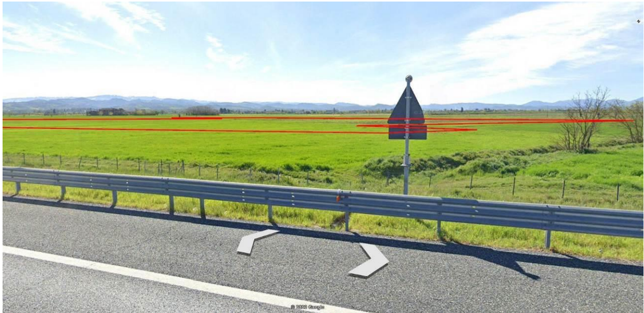
Figura 8-20 - Fotografia da terra: punto di ripresa 6
