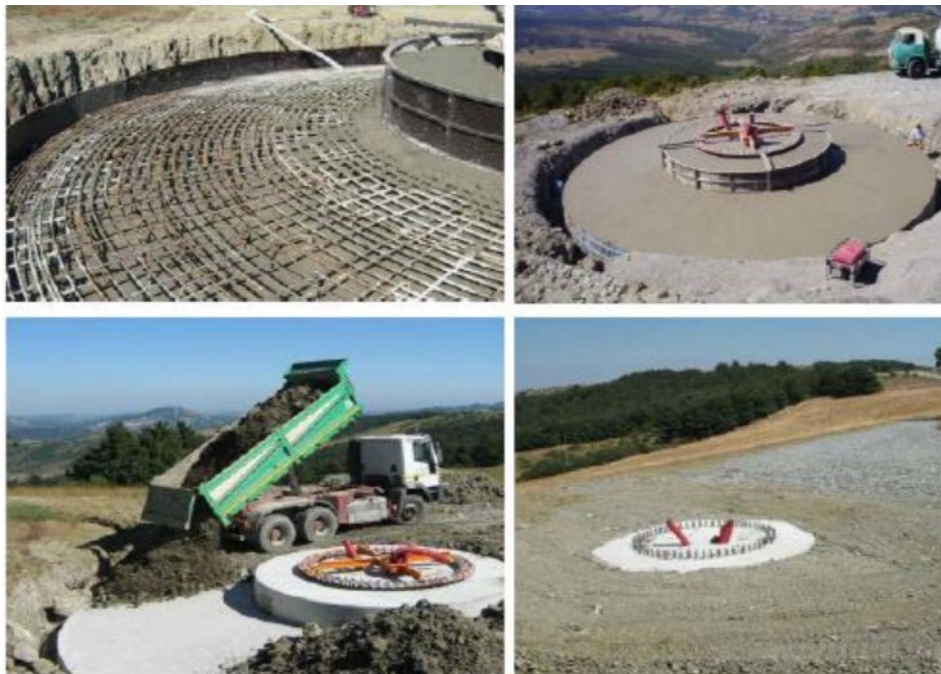
Figura 4 – Fasi di realizzazione del plinto di fondazione dell'aerogeneratore.
