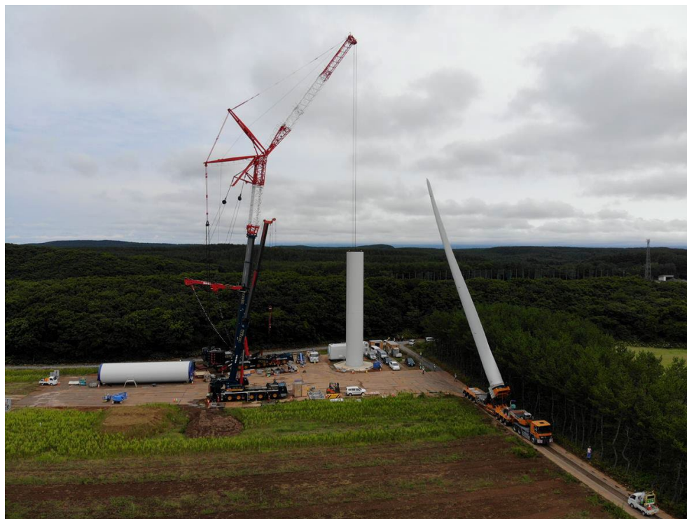
Figura 5 – Fase di montaggio dell'aerogeneratore con torre principale in azione e trasporto della pala con sistema blade lifter, per ridurre la lunghezza dei mezzi di rimorchio.
