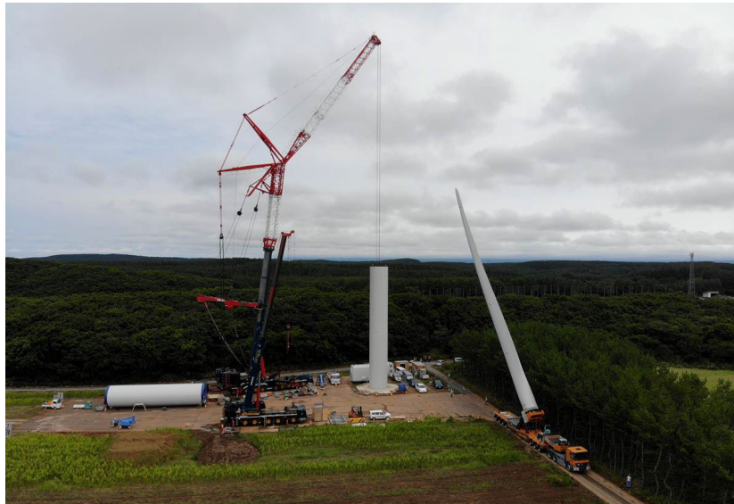
Figura 4 – Montaggio dell'aerogeneratore con gru principale.
