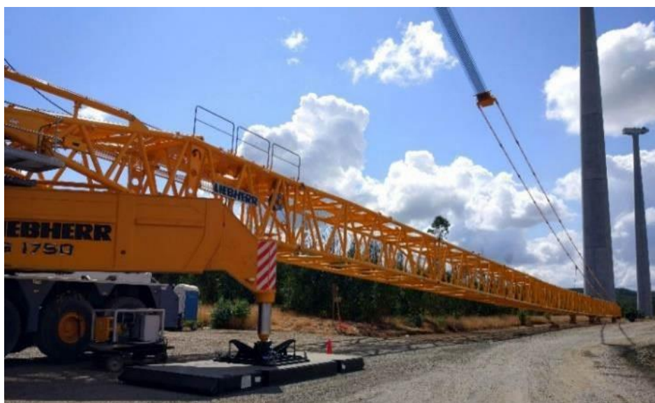
Figura 14 – Fasi di montaggio della gru principale.
