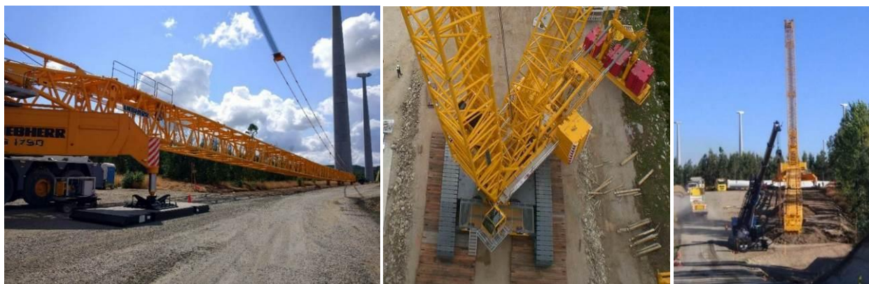
Figura 24 - Fasi di montaggio della gru principale.
