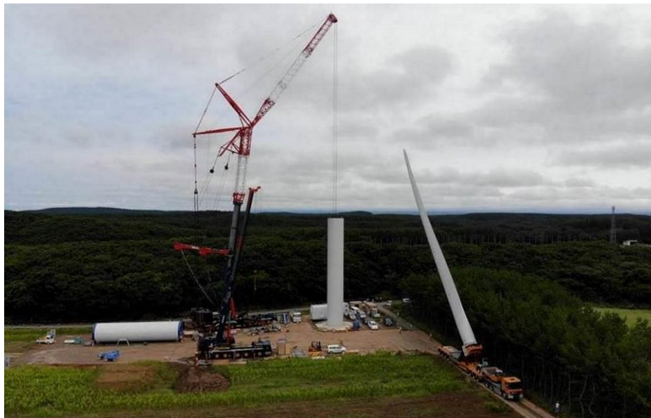
Figura 15 – Fasi di montaggio della torre dell'aerogeneratore.
