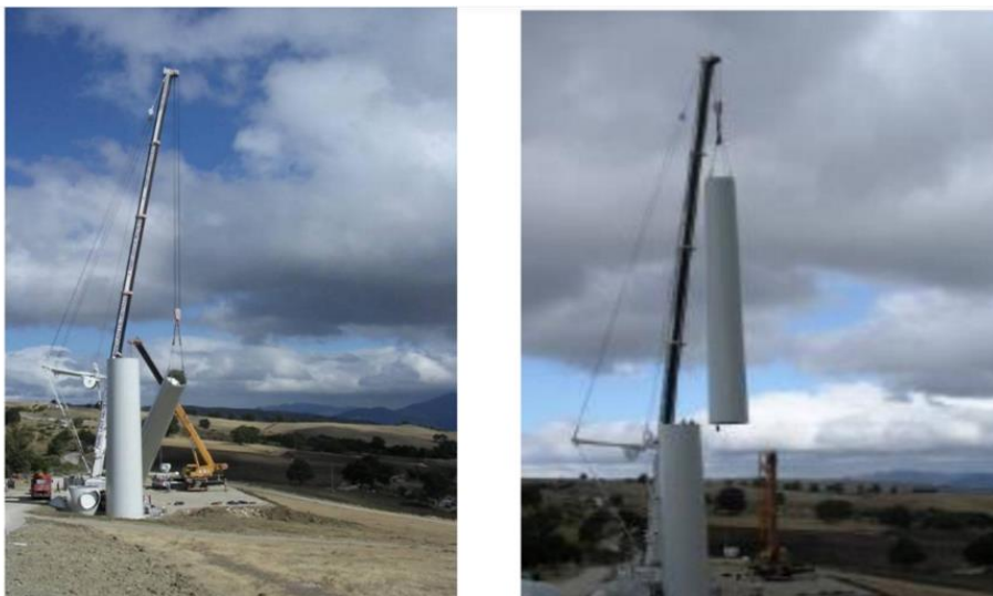
Figura 26 – Fasi di montaggio della torre dell'aerogeneratore.
