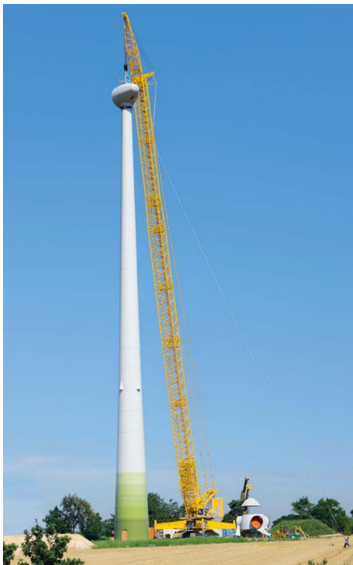
Figura 3 – Gru a traliccio da 600 ton con altezza netta sotto il gancio 170 m.
