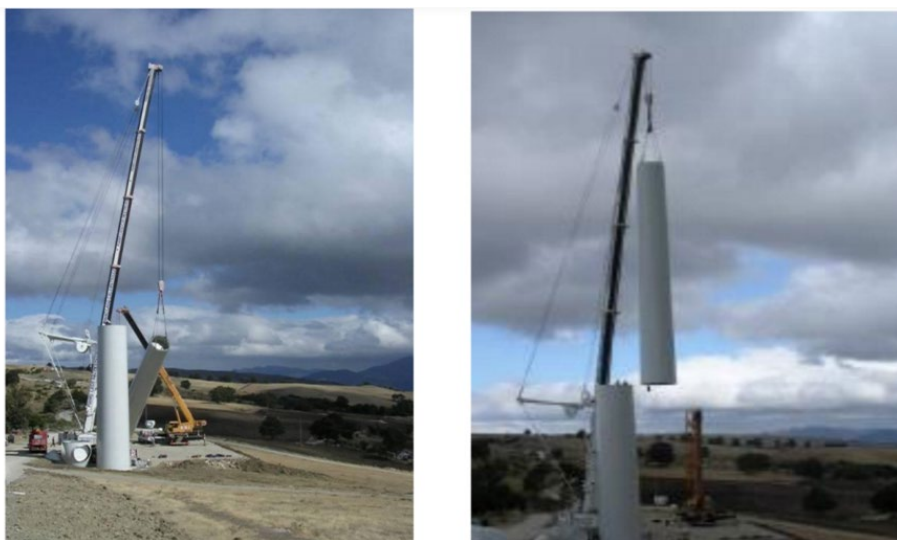
Figura 4 – Fasi di montaggio della torre dell'aerogeneratore.
