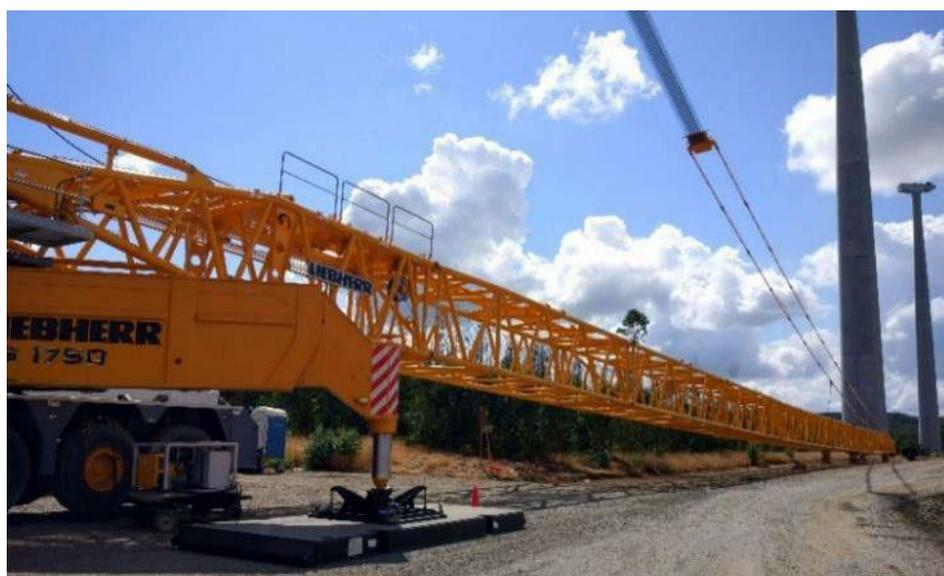
***Figura 12 – Fasi di montaggio della gru principale.***
