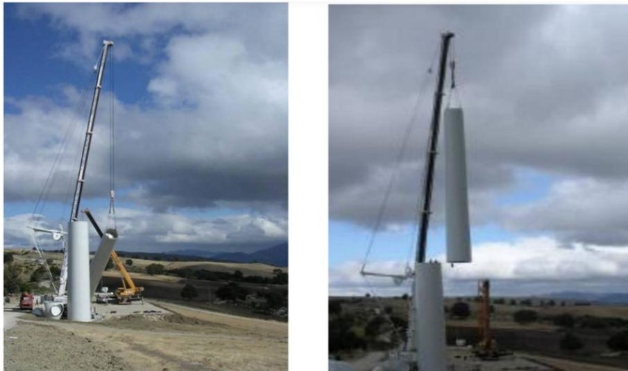
***Figura 27 – Fasi di montaggio della torre dell'aerogeneratore.***
