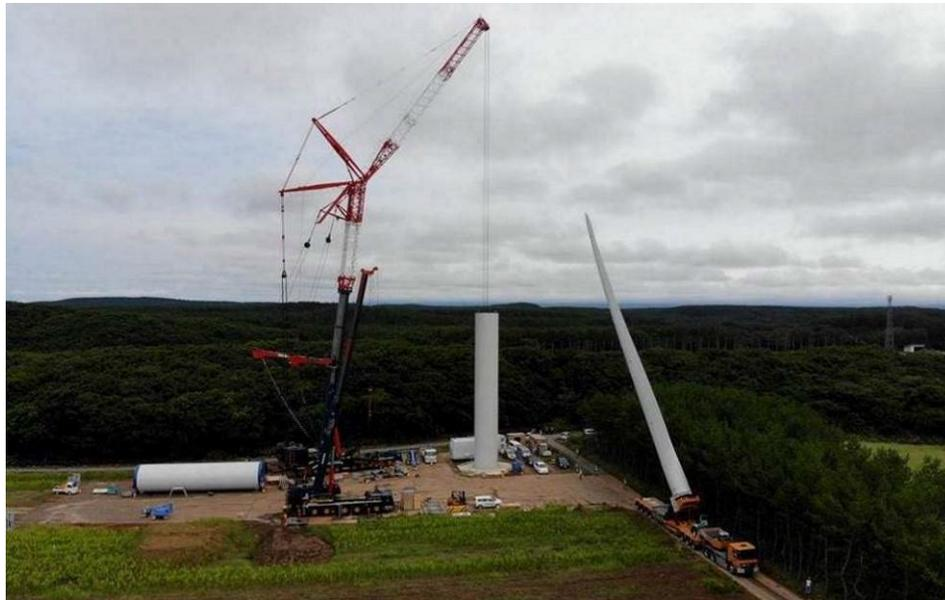
*Figura 13 – Fasi di montaggio della torre dell'aerogeneratore.*
