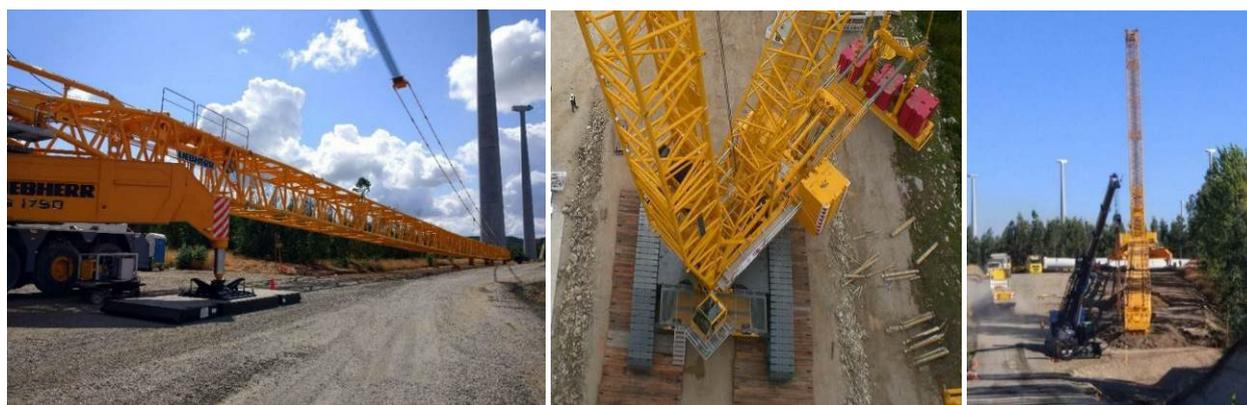
*Figura 25 - Fasi di montaggio della gru principale.*
