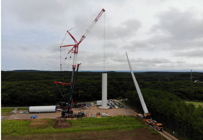
Figura 3 – Montaggio dell'aerogeneratore con gru principale.
