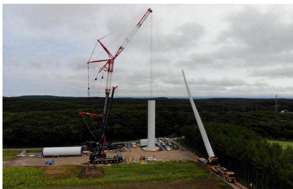
Figura 13 – Fasi di montaggio della torre dell'aerogeneratore
