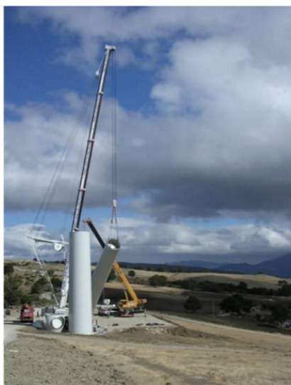
Figura 27 – Fasi di montaggio della torre dell'aerogeneratore
