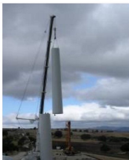
Figura 27 – Fasi di montaggio della torre dell'aerogeneratore
