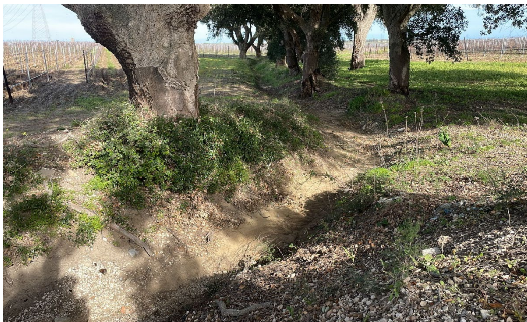
Fig. 5.5.2.3 - Stato dei luoghi da sopralluogo (vista dal centro strada verso Nord)
