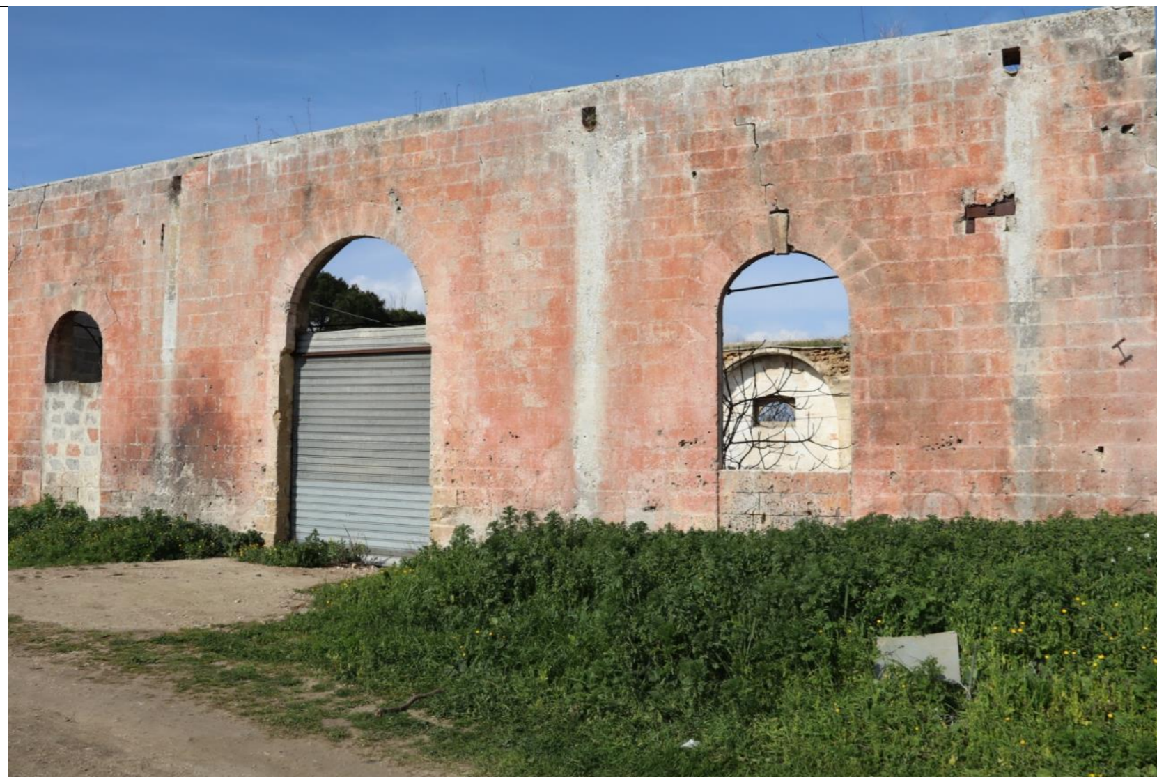
Masseria Restinco, particolare dell'ingresso. Si noti l'assenza di coperture.
