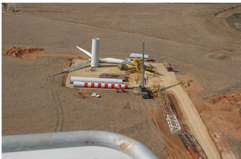
Figura 2 – Piazzola per il montaggio dell'aerogeneratore
