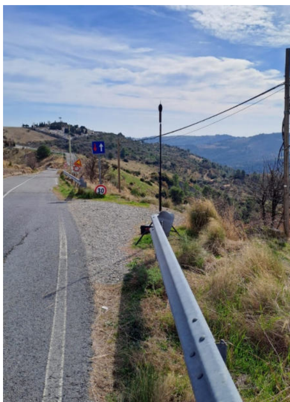
Figura 11: Punto misura stradale
