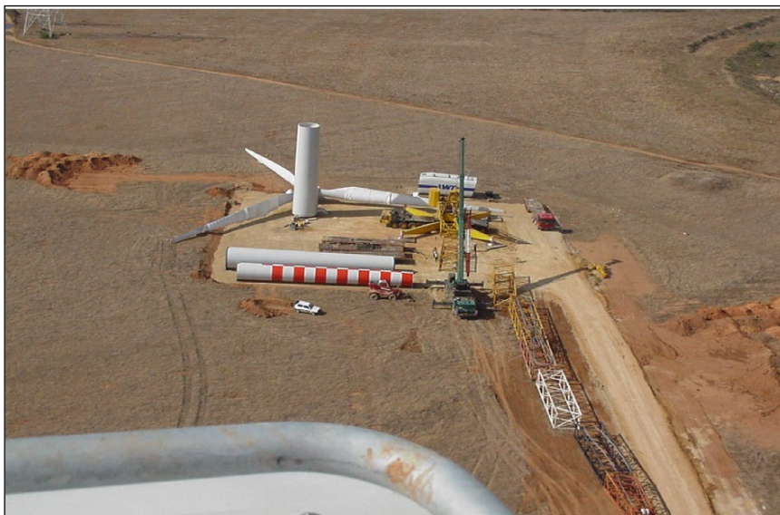
Foto 1. Piazzola per il montaggio dell'aerogeneratore
