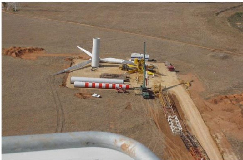
Figura 2 – Piazzola per il montaggio dell'aerogeneratore
