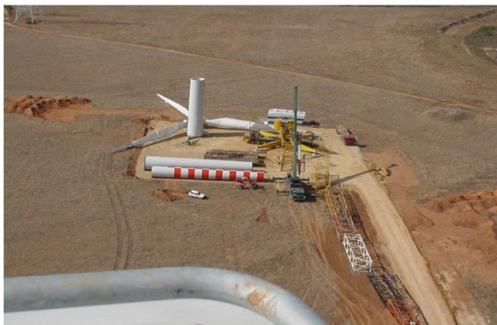
Figura 11 – Piazzola per il montaggio dell'aerogeneratore
