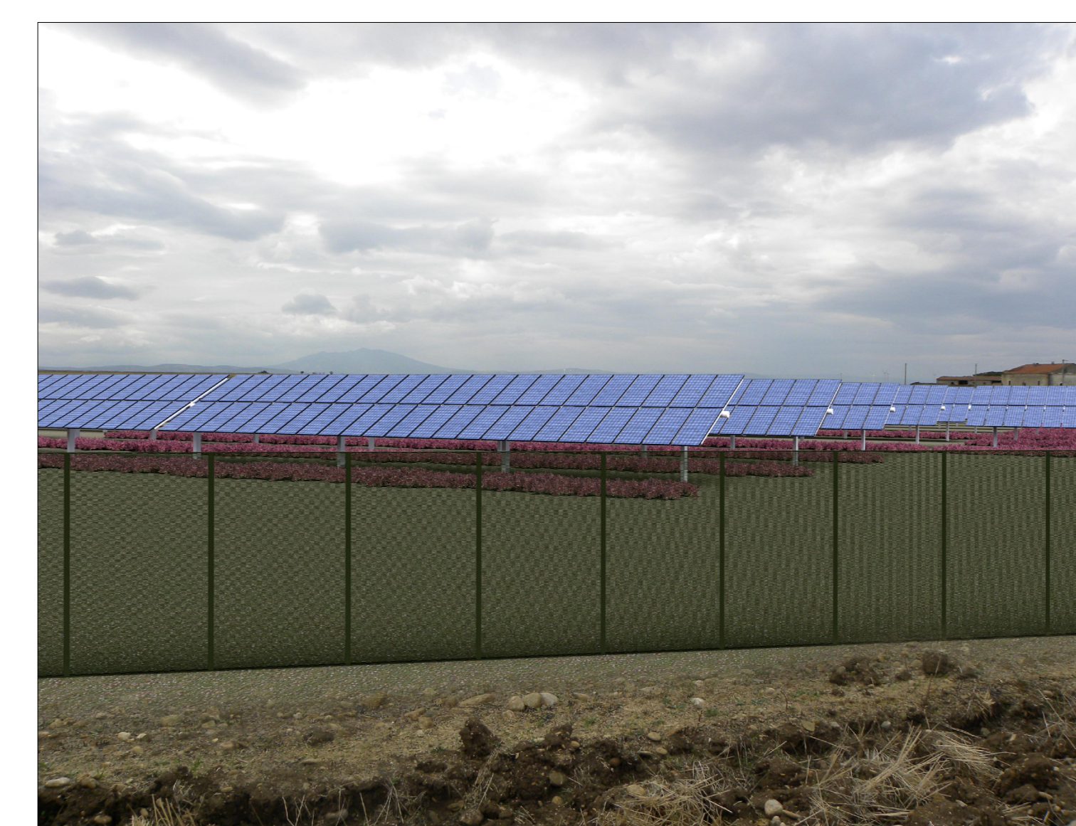
Stato di progetto del campo Agrivoltaico, con recinzione perimetrale realizzata con rete elettrosaldata a maglia rettangolare, zincata e verniciata RAL 6018 - Light Green.
