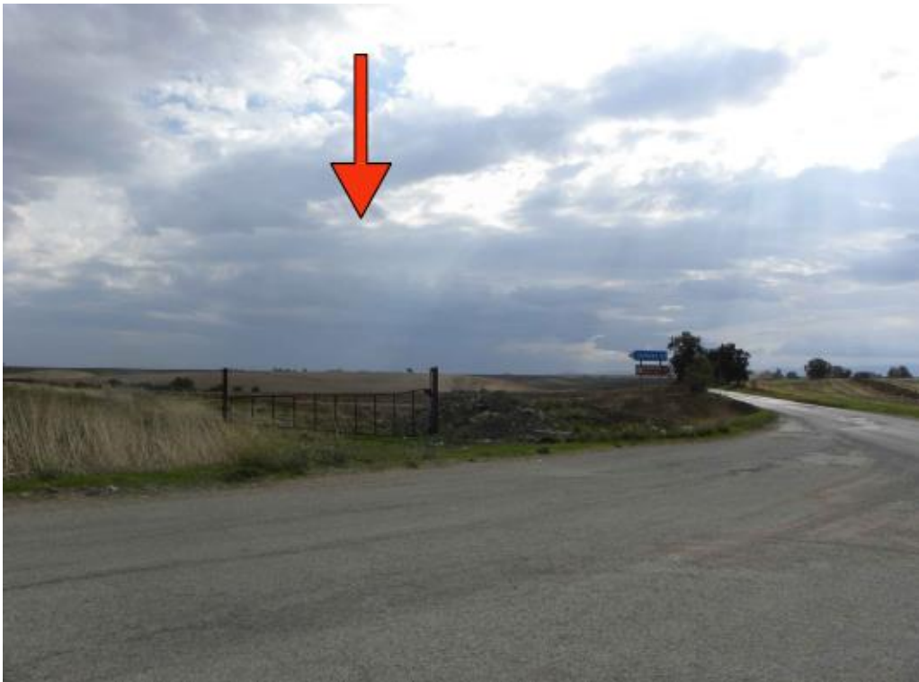
Figura 8: Veduta area di accesso dell'impianto agrivoltaico
