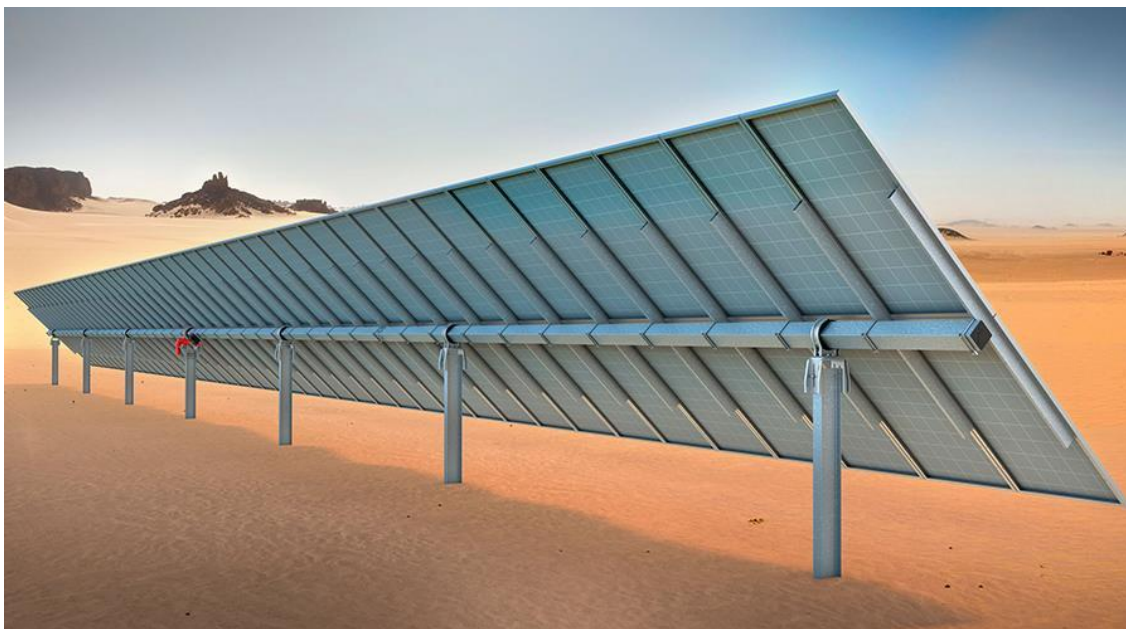
Figura 2-1: Immagine qualitativa della struttura di supporto
