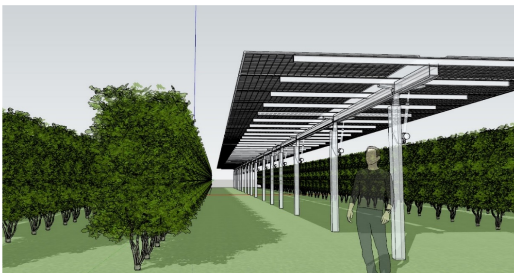
Figura 9 - Immagine impianto, altezza media 2,8 mt
