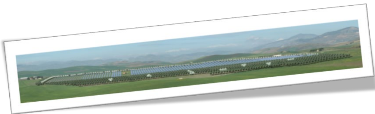
Figura 28 - Impianto fotovoltaico da 5 MW, "Heliospower", Monreale /(PA) 2010
