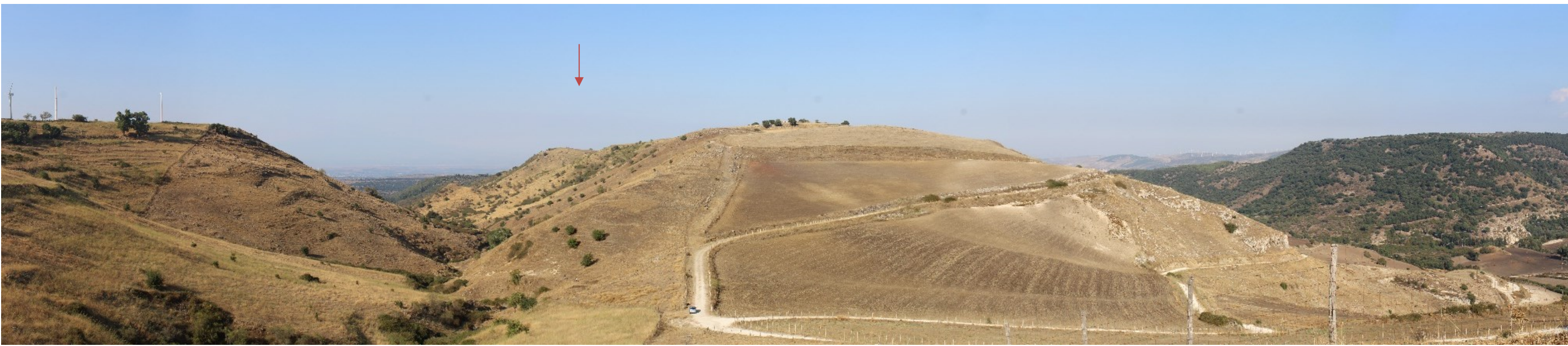
P2 – Strada impianto eolico SS124 – Comune di Vizzini (CT) – panoramica estesa – Stato di progetto
